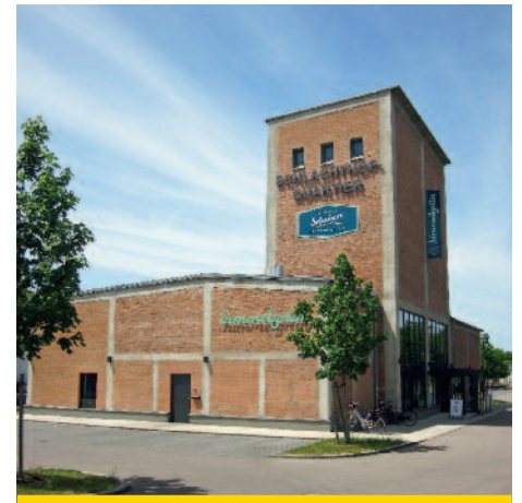
Kesselhaus des Schlachthof-Areals
