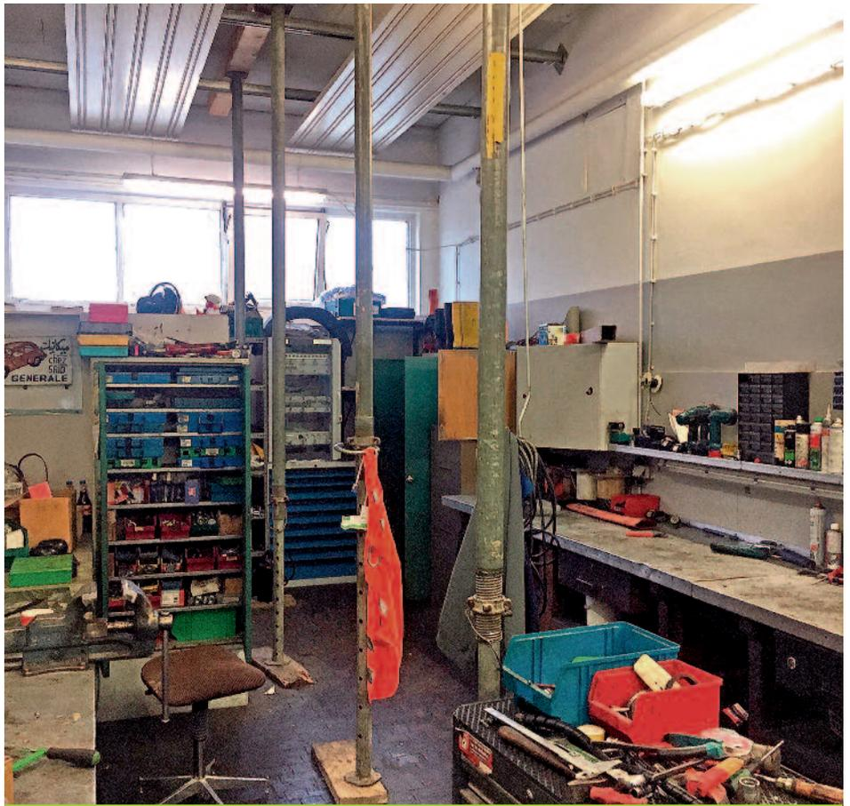
In der Werkstatt muss die Decke provisorisch abgestützt werden
